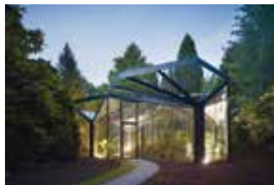
Objekt 80 BOG. Schauhaus Botanischer Garten Adletshusen 78, Grünigen Architekt idA buehrer wuest architekten ag, Zürich Bauherrschaft ZKB Kaufmännisches Gebäudemanagement LGK, Dübendorf
