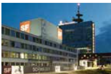
Objekt 106 Aufwertung Zugangsbereich Schweizer Fernsehen, Fernsehstrasse 1–4, Zürich Architekt Bünzli & Courvoisier Architekten AG/ HinderSchlatterFeuz, Zürich Bauherrschaft SRG SSR idée suisse, Bern
