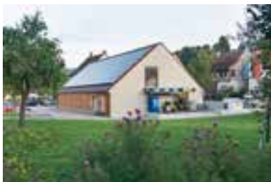
Objekt 79 Volg & Dorfplatz Trüllikon Diessenhoferstrasse 4, Trüllikon Architekt Schmid Schärer Architekten, Zürich Bauherrschaft Gemeinde Trüllikon
