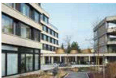
Objekt 44 Seniorenresidenz und Pflegeheim Ruggacker, Bremgartnerstrasse 39, Dietikon Architekt Niedermann Sigg Schwendener Architekten, Zürich Bauherrschaft Stadt Dietikon
