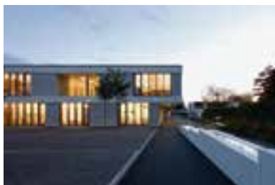
Objekt 41 Erweiterung und Sanierung Primarschulhaus Meiliwiese, Hinwil Architekt raumfindung architekten eth fh sia, Rapperswil Bauherrschaft Primarschulgemeinde Hinwil
