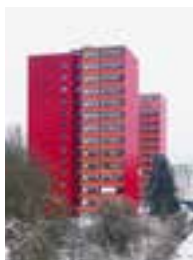
Objekt 103 Wohnsiedlung Glanzenberg Glanzenbergstrasse 26/28, Dielsdorf Architekt Galli Rudolf Architekten AG BSA ETH, Zürich Bauherrschaft Siedlungsgenossenschaft Eigengrund, Zürich
