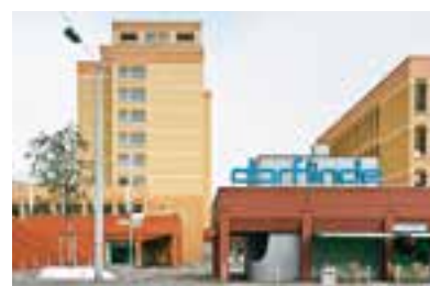
Objekt 108 Gesamtsanierung Dorflinde, Schwammen- dingenstr. 37/39/41, Dorflindenstr. 2/4, Zürich Architekt Gruppe für Architektur GmbH/neff neumann architekten ag, Zürich Bauherrschaft Stadt Zürich Immobilienbewirtschaftung/ Liegenschaftenverwaltung, vertr. durch Amt für Hochbauten, Zürich
