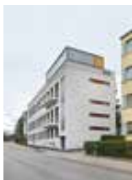
Objekt 40 Umbau Telefonzentrale Wollishofen Kalchbühlstrasse 4, Zürich Architekt Rossetti + Wyss Architekten, Zollikon Bauherrschaft Kalchbühl Raum AG, Zürich
