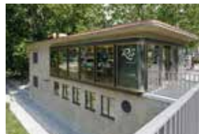
Objekt 21 Rio Bar Zürich Gessnerallee 17, Zürich Architekt S2 Stucky Schneebeili Architekten, Zürich Bauherrschaft Stadt Zürich, Amt für Hochbauten, Zürich
