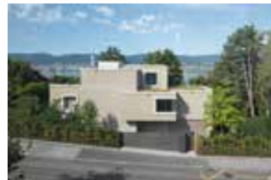
Objekt 102 Wohnhaus Schiedhaldenstrasse Schiedhaldenstrasse 24, Küsnacht Architekt Gret Loewensberg Architekten GmbH, Zürich Bauherrschaft Erbgemeinschaft Leuenberger, Zürich
