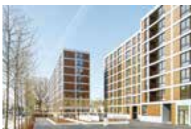
Objekt 107 Siedlung Living 11 Schaffhauserstrasse 561–595, Zürich Architekt Bünzli & Courvoisier Architekten AG, Zürich Bauherrschaft ASIG Wohngemeinschaft, Zürich → 28
