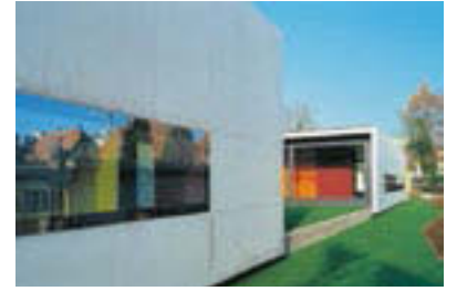
Objekt 84 Kindergärten Zentral Schulstrasse 7, Dietikon Architekt Ken Architekten BSA, Zürich Bauherrschaft Stadt Dietikon, Dietikon
