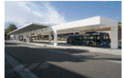
Objekt 78 Bushof Meilen Architekt Oliver Schwarz Architekten, Zürich Bauherrschaft Politische Gemeinde Meilen, Meilen
