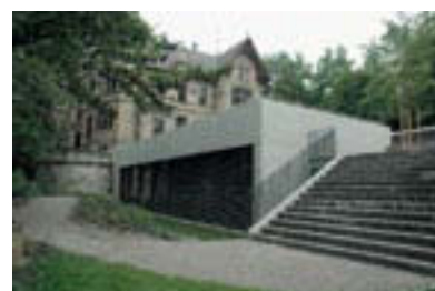
Objekt 09 Anbau Freie Schule Winterthur Heiligbergstrasse 54, Winterthur Architekt Ruedi Lattmann Architektur + Design AG, Winterthur Bauherrschaft Freie Schule Winterthur, Winterthur
