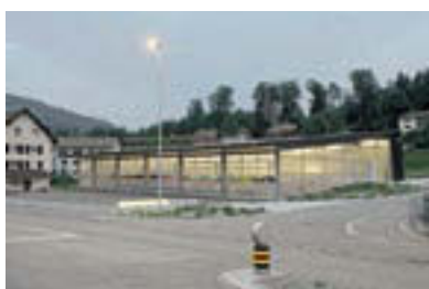
Objekt 07 Neubau Feuerwehrdepot Wald Eschenstrasse 1, Wald Architekt moos.giuliani.herrmann.architekten, Uster Bauherrschaft Politische Gemeinde Wald, Wald
