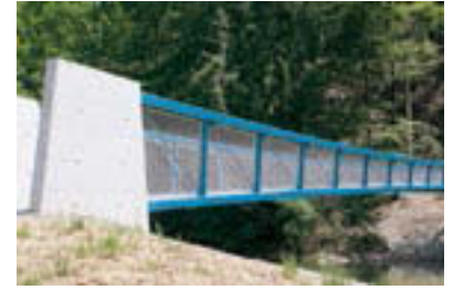
Objekt 75 Fussgängerbrücke «Im Schiffli» Hirzel/Neuheim Architekt Wolf, Kropf & Partner AG, Zürich Bauherrschaft Baudirektion Kanton Zürich Tiefbauamt, Zürich
