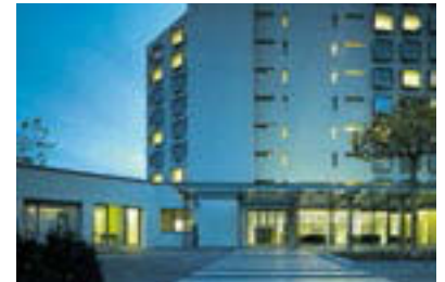
Objekt 42 Umbau und Sanierung Pflegezentrum Entlisberg, Paradiesstrasse 45, Zürich Architekt Keller Landolt Partner Architekten SIA, Zürich Bauherrschaft Amt für Hochbauten der Stadt Zürich, Zürich
