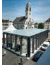
Objekt 83 Kirchplatz Dietikon Architekt Prof. Ueli Zbinden, Arch. ETH BSA SIA, Zürich Bauherrschaft Stadt Dietikon, Dietikon
