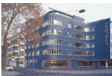
Objekt 08 Hotel Greulich Herman Greulich-Strasse 56, Zürich Architekt Romero & Schaeffle Architekten AG Zürich Bauherrschaft Dr. Thomas Brunner, Zürich
