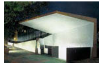
Objekt 81 Zugang Parkaus Feldegg Seefeldstrasse, Zürich Architekt Detlef Schulz, Architekt ETH SIA, Zürich Bauherrschaft Amt für Hochbauten der Stadt Zürich, Zürich
