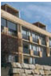
Objekt 16 Mehrfamilienhaus Sunny Woods Im oberen Boden 165, Zürich-Höngg Architekt Beat Kämpfen Architekt, Zürich Bauherrschaft Kämpfen Bau GmbH, Zürich
