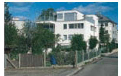
Objekt 09 Mehrfamilienhaus Bernina Berninastrasse 113, Zürich-Oerlikon Architekt Ulrich Schlegel Architekt ETH SIA SWB, Zürich Bauherrschaft Stockwerkeigentumsgemeinschaft Bernina, Zürich
