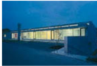
Objekt 02 Neubau Schulanlage Gutenswil Niedereggweg 22, Gutenswil Architekt Peter Kunz Architekt BSA, Winterthur Bauherrschaft Schulgemeinde Volketswil, Volketswil
